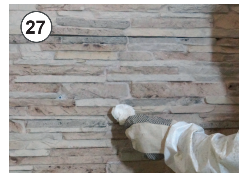
27 - Prestare attenzione a non sporcare durante l'applicazione dell'ossido, in caso accidentale ripulire immediatamente con carta assorbente 27 - Pay attention not to dirty during the application of the oxide, in case of accidental clean up immediately with absorbent paper
