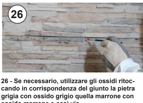
26 - Se necessario, utilizzare gli ossidi ritocando in corrispondenza del giunto la pietra grigia con ossido grigio quella marrone con ossido marrone e così via 26 - If necessary, use the other oxides by retouching the gray stone with gray oxide at the joint, the brown one with brown oxide and so on
