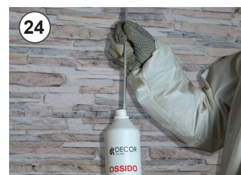
24 - Mescolare con asta metallica per rimuovere le parti solidificate sul fondo del contenitore! 24 - Mix, by metal bar, to remove solidified parts
