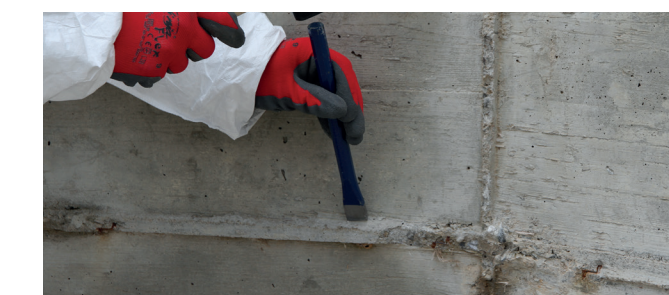
1 - Eliminazione delle imperfezioni 1 - Removal of imperfections
