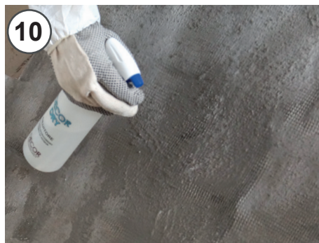
10 - Inumidire con acqua nebulizzata sul retro del pannello per migliorare la presa della schiuma poliuretanic 10 - Moisten with water spray on the back of the panel, to improve grip of the polyurethane foam
