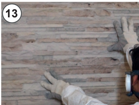
13 - Applicare il pannello sulla parete con leggera pressione 13 - Applying of panel on the wall with light pressure
