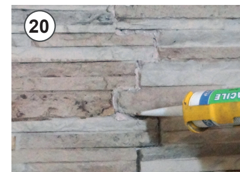
20 - Stuccare i fori di fissaggio provvisori 20 - Grouting of temporary mounting holes
