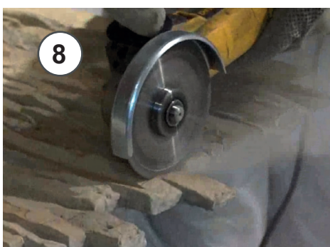
8 - Taglio dei pannelli mediante smerigliatrice 8 - Cutting of panels using the Flex
