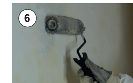
6 - Se il fondo è in buone condizioni, applicare semplicemente una mano di primer consolidante 6 - If the paint on the wall is in good condition, apply a coat of consolidating primer
