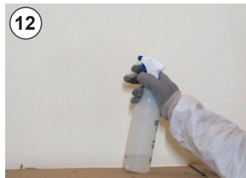
12 - Inumidire il muro con acqua nebulizzata per migliorarne la presa 12 - Moisten with water spray on the wall to improve grip
