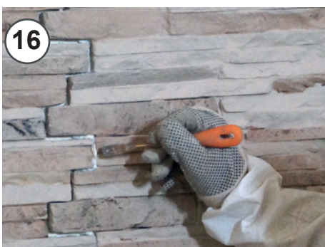
16 - Pulire i giunti dai residui di schiuma fuoriuscita mediante l'uso di un cacciavite 16 - Joints cleaning from foam residues
