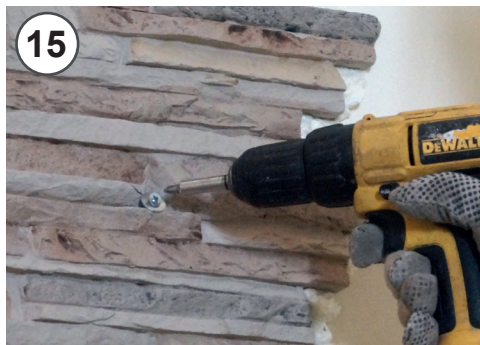
15 - Ad incollaggio avvenuto, rimuovere le viti e rondelle precedentemente posizionate 15 - On occurred glueing, removing screws and washers previously positioned
