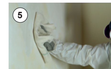
5 - Rimuovere la polvere con un panno umido 5 - Remove the dust with a damp cloth
