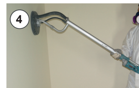
4 - In caso di pittura screpolata carteggiare a mano o con levigatrice 4 - In the case of cracked paint, sand by hand or with a sander
