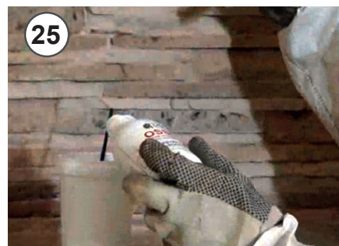
25 - Versare parte di ossido miscelato in un contenitore aperto 25 - Pour the mixed oxide into an open little container
