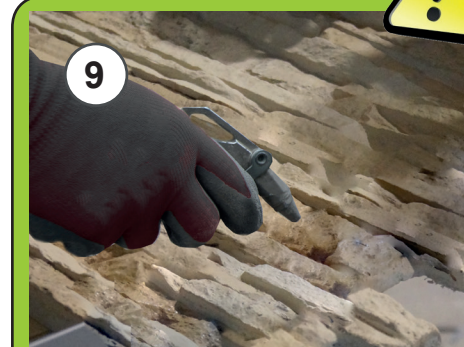
9 - Pulizia da polvere e residui 9 - Remove dust and debris
